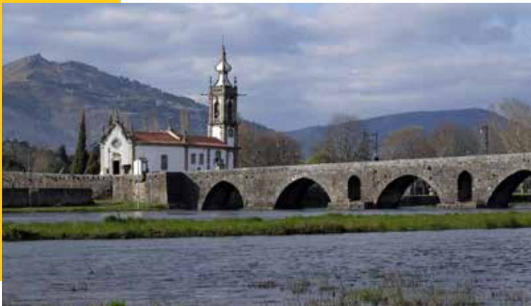
Ponte romano-medieval sobre o rio Lima. Ponte de Lima, Portugal
