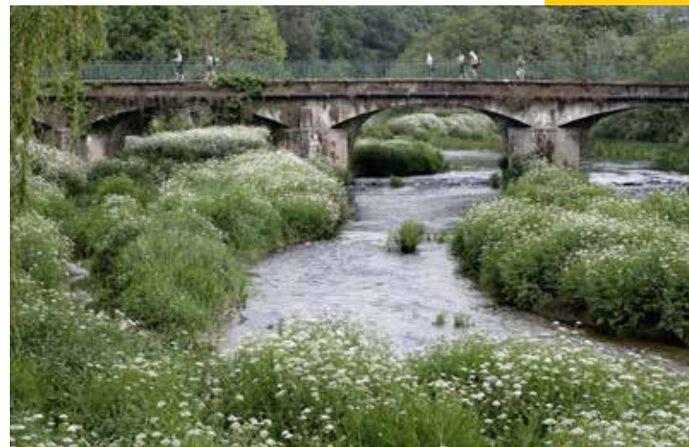
Ponte sobre o rio Umia. Caldas de Reis, Pontevedra, Galiza, Espanha
